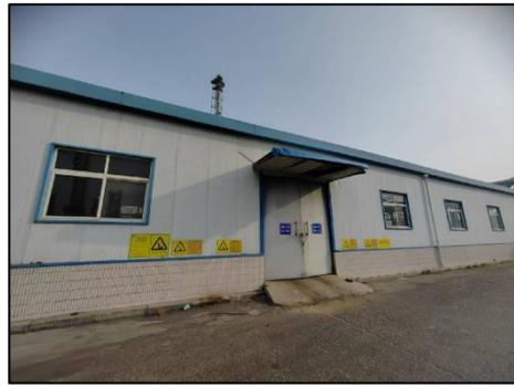
1、危险废物贮存仓库数量：危废仓库 1 个，面积 540 m<sup>2</sup>。用于厂区内产生及收集的危险废物的暂存，已进行防渗处理，每个暂存区都设有应急池。
