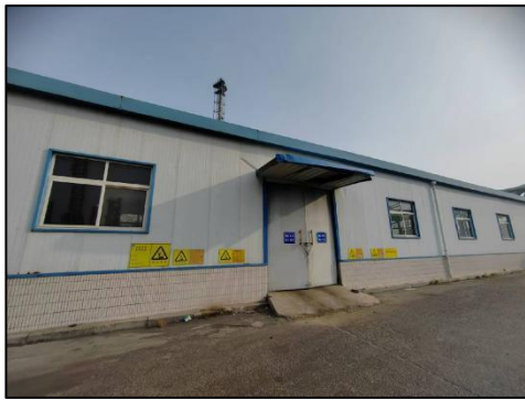
危险废物综合仓库
